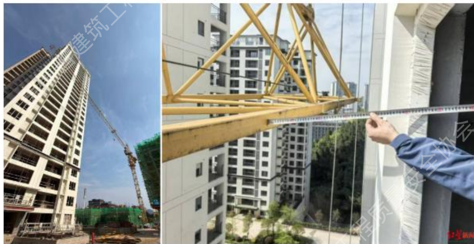
▲塔吊的起重臂几乎贴上旁边已经建好的高层建筑。
