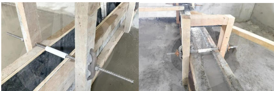
图 6.11.4-1 反坎加固措施
