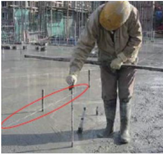
图 6.8.3-1 采用结构+0.500m 标高控制线控制标高 图 6.8.3-2 采用钢筋三脚架控制标高
