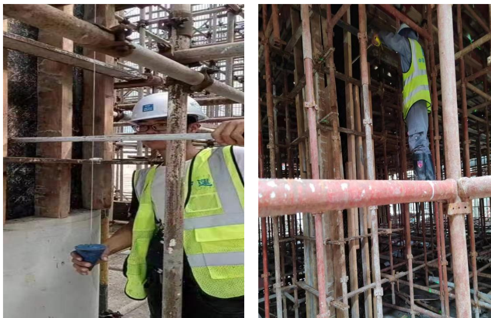
图 6.7.3-1 柱、墙垂直度进行检查
