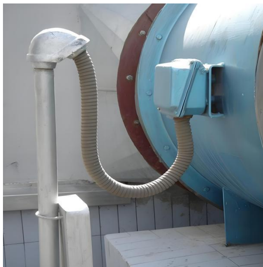
图 11.2.8.2 设备与管道之间柔性连接
