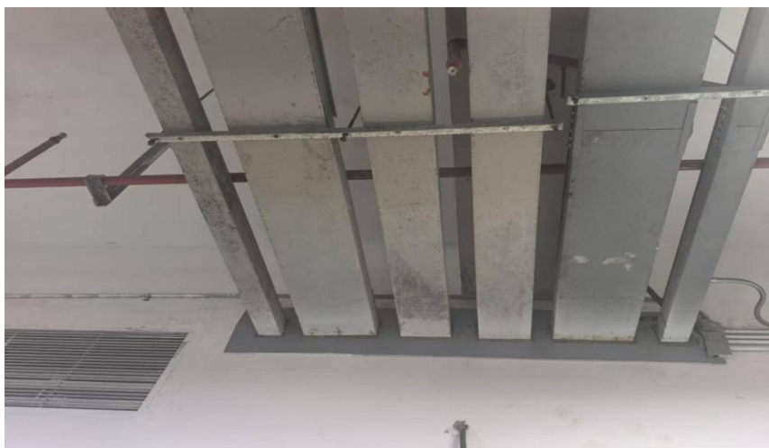
图 12.6.3.3-1 桥架封堵规范标准
