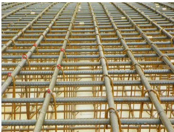
图 5.8.3 人防地下室底板拉筋布置
