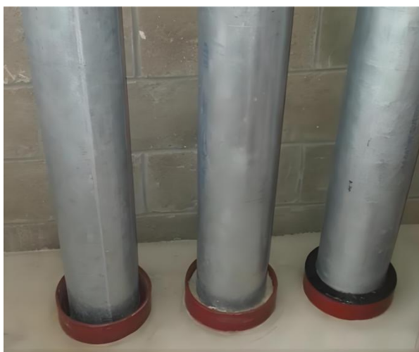
图 11.1.3.3 管道钢套管预埋
