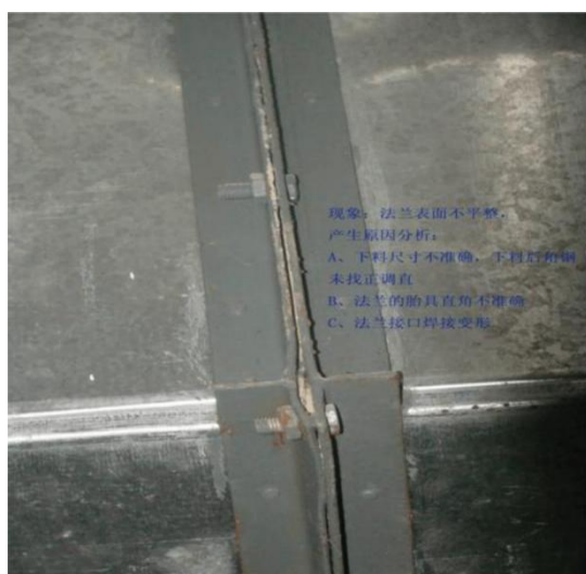
图 11.5.3.1 风管连接处漏风
