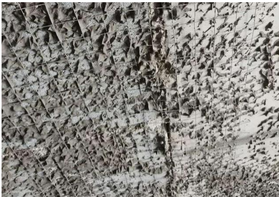
图 13.1-3 拉毛处理样板
