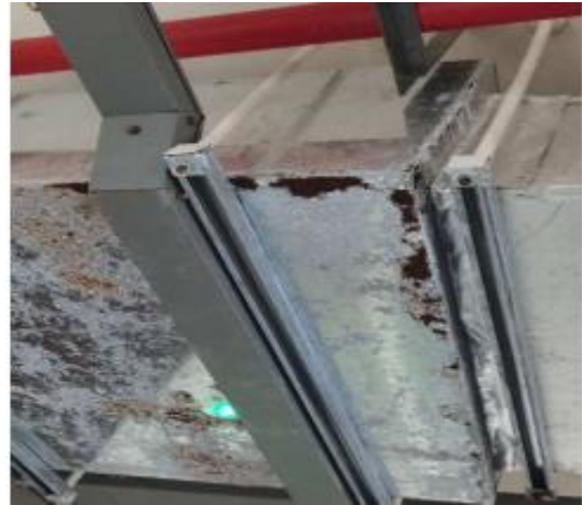
图 11.5.1.2 风管产生变形
