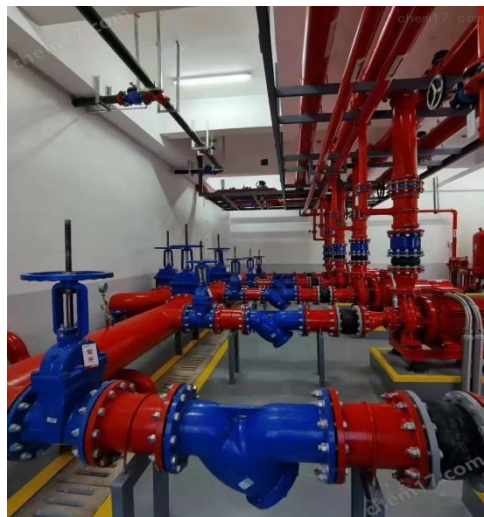
图 12.1.6.3-2 阀门选型安装标准做法
