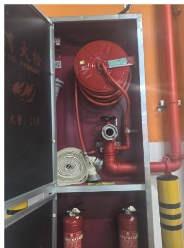
图 12.2.3-2 消火栓标准安装标准做法
