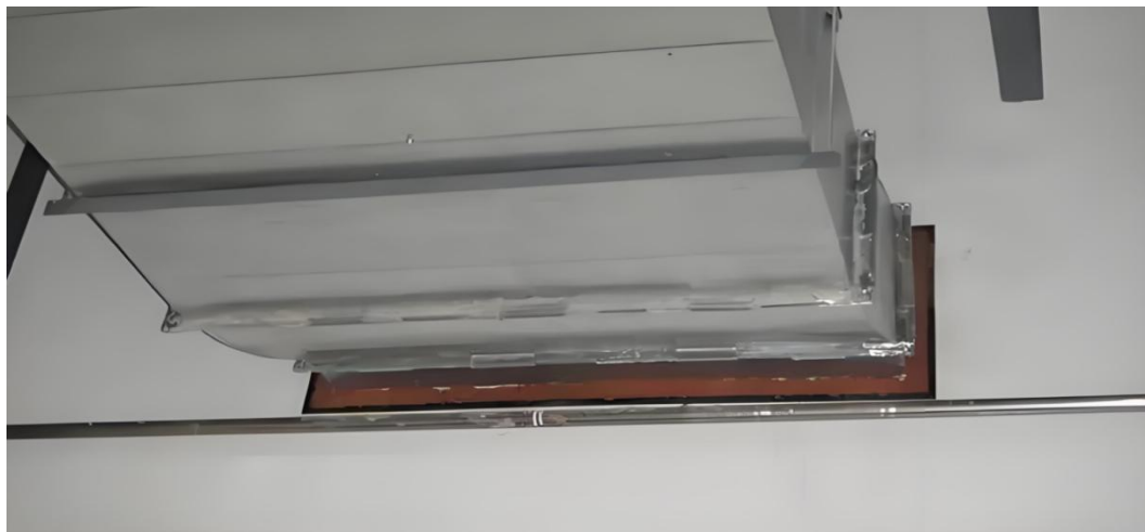
图 11.5.5.3 穿墙风管套管及封堵
