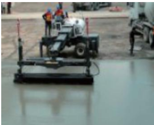
图 6.8.3-3 激光找平机械找平
