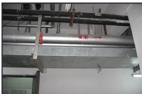
图 11.3.6.1 桥架平行敷设于给水管下方
