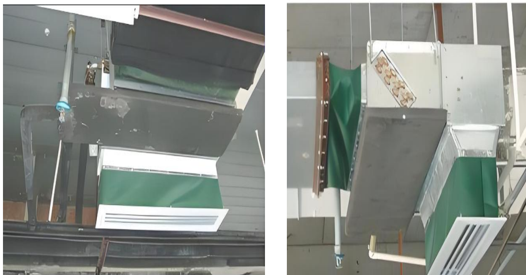
图 11.5.6.2 风管末端自由端安装
