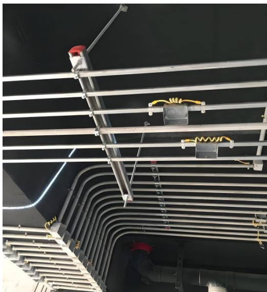
图 11.2.2.3 金属电气线管接地跨接
