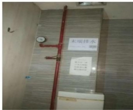
图 12.3.1-2 末端排水阀门等安装不符合规范
