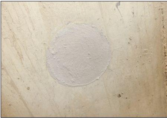
图 10.2.3-5 聚氨酯防水涂料封闭螺杆洞示意图
