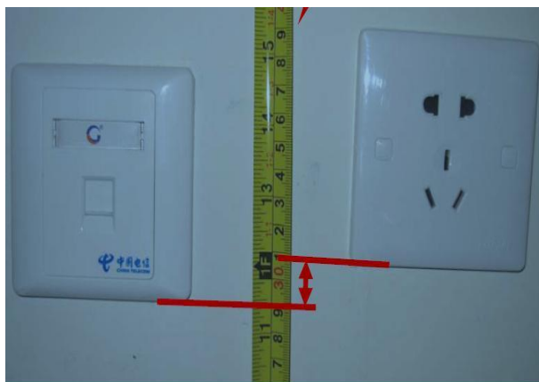
图 11.1.1.2 相邻强、弱电插座安装标高不一致
