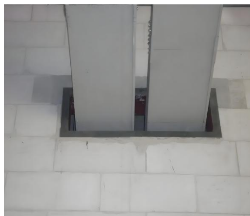
图 11.3.2.3 桥架穿墙套管
