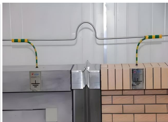
图 11.7.2.4 接地圆钢搭接
