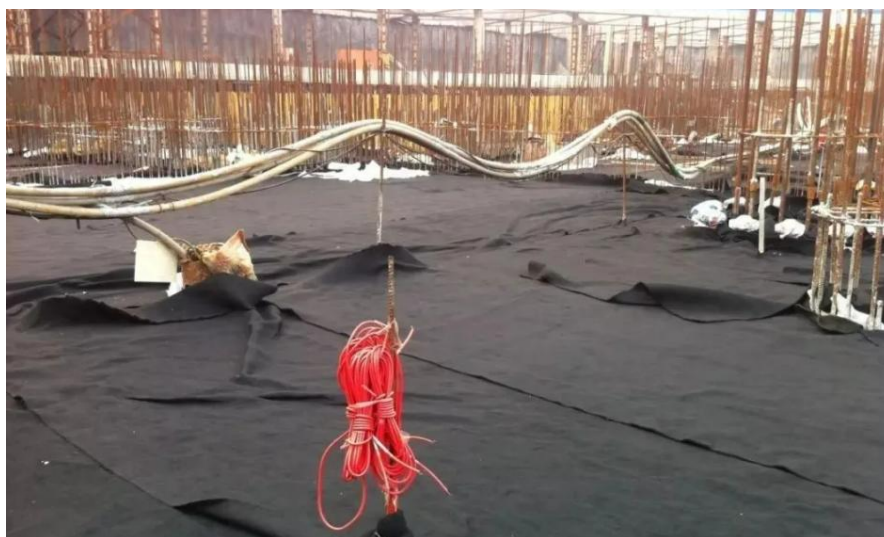
图 6.14.3-2 大体积混凝土保温保湿措施
