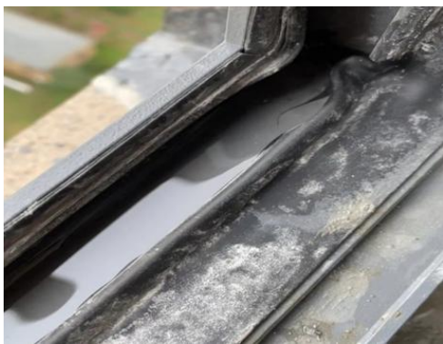
图 10.5.1-3 密封条老化后渗水
