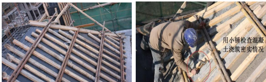
图 6.13.3-1 斜屋面模板加固措施
