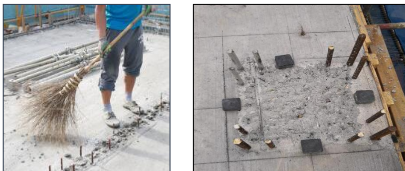
图 7.3.3.3-1 预制剪力墙、柱基层处理意图
