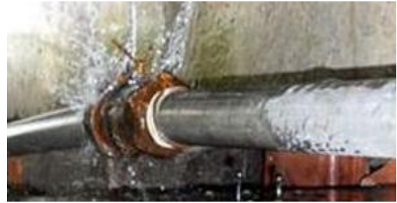
图 10.8.1-2 排水管道穿楼板处洞口堵塞不密实
