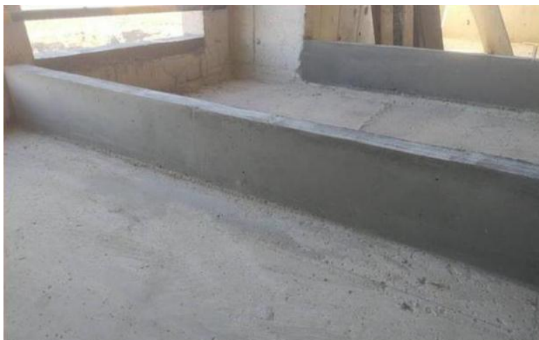
图 6.11.1-3 卫生间反坎成型图片
