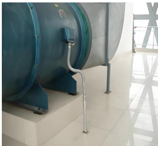
图 11.2.8.1 设备机与管线刚性连接
