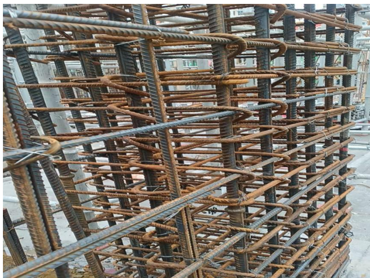
图 5.10.3 短肢剪力墙钢筋满扎
