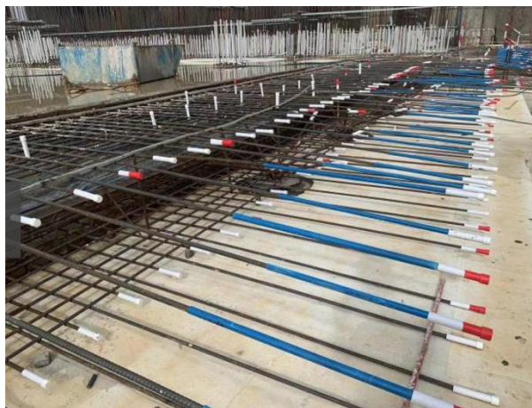
图 6.12.3 后浇带预留钢筋的保护措施
