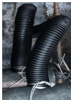
图 7.3.2-1 套筒进出浆孔管道安装弯折、扭曲
