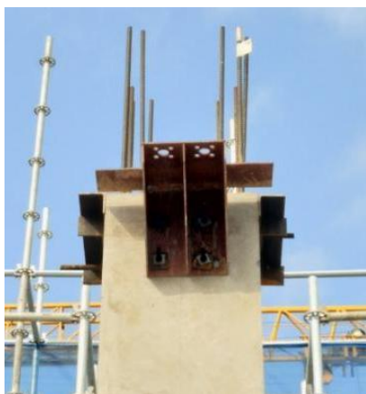
图 7.5.3-2 竖向构件安装牛腿
