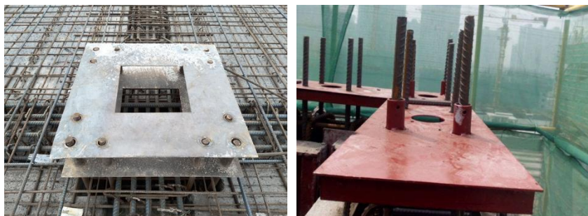
图 7.4.3-3 柱、墙接头钢筋定位工具
