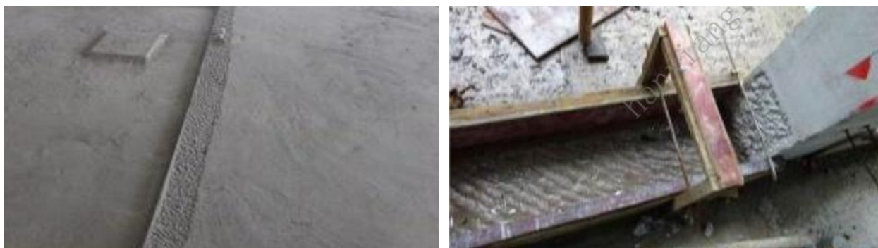
图 6.11.3-2 浇筑混凝土反坎前凿毛到位
