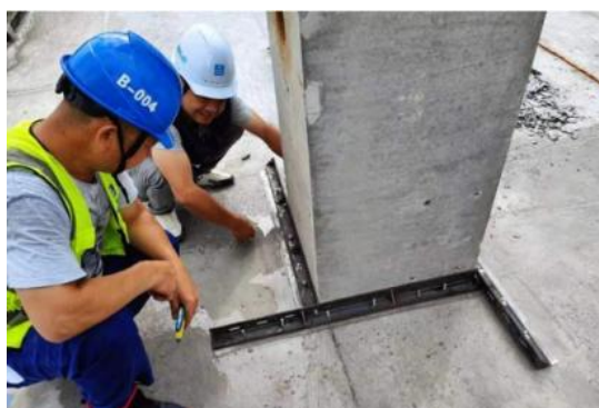
图 7.3.3.3-3 工具式装置装封仓示意图
