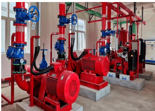
图 12.1.1.3-1 卧式泵规范安装
