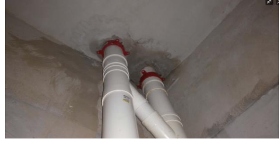
图 10.8.1-2 排水管道穿楼板处洞口堵塞不密实
