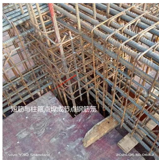
图 5.5.3 梁柱节点处采用箍筋笼
