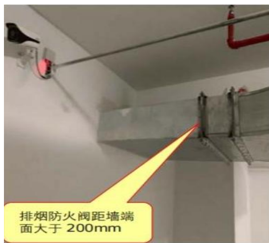
图 11.5.4.2 阀体开关安装错误
