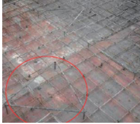
图 6.8.3-1 采用结构+0.500m 标高控制线控制标高 图 6.8.3-2 采用钢筋三脚架控制标高
