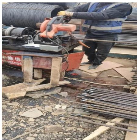
图 5.7.2 采用专用设备切平端部
