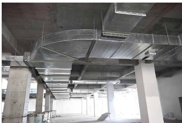
图 11.5.1.3 镀锌风管安装
