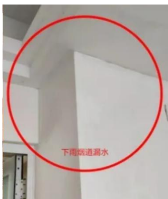
图 10.11.1-1 顶楼厨房烟道、管道井与顶板 图 10.11.1-2 卫生间墙面渗漏水导致墙体潮湿、发霉 交接处渗漏
