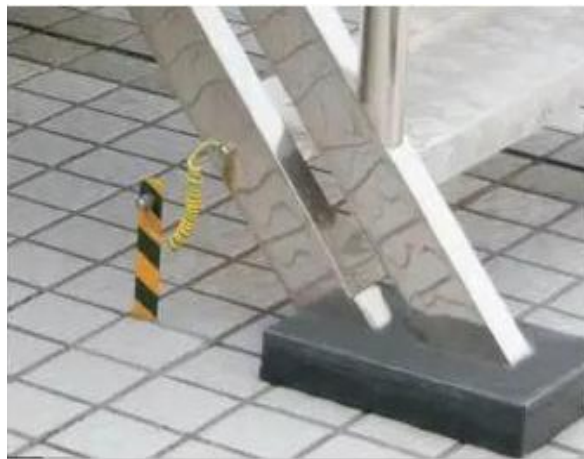
图 11.7.5.3 屋面金属构件接地保护
