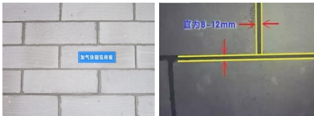
图 8.2.3-1 灰缝宽度
