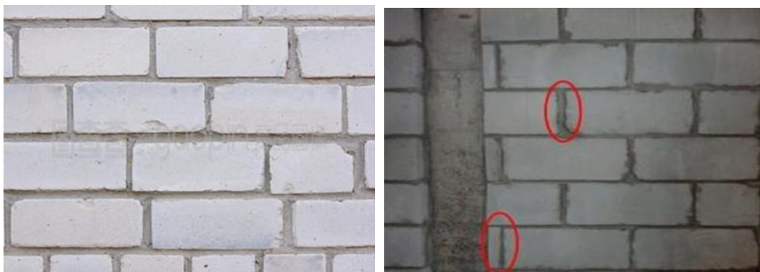
图 8.2.1-2 灰缝表面不平整
