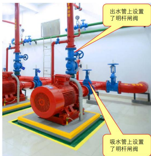
图 12.1.6.3-1 阀门选型安装标准做法
