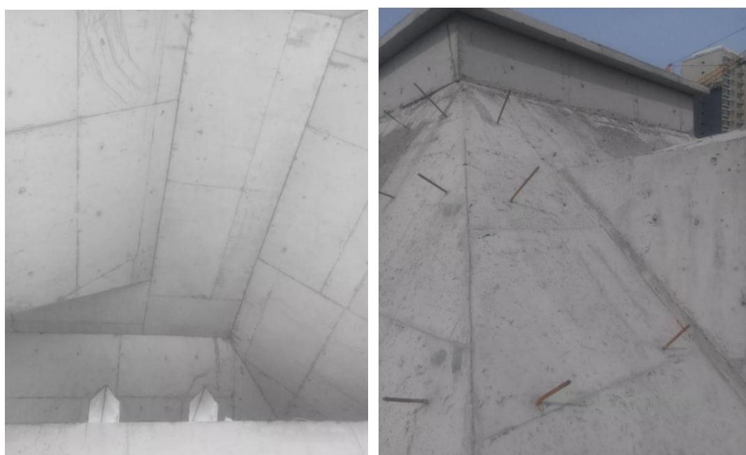
图 6.13.3-2 斜屋面混凝土浇筑成型效果
