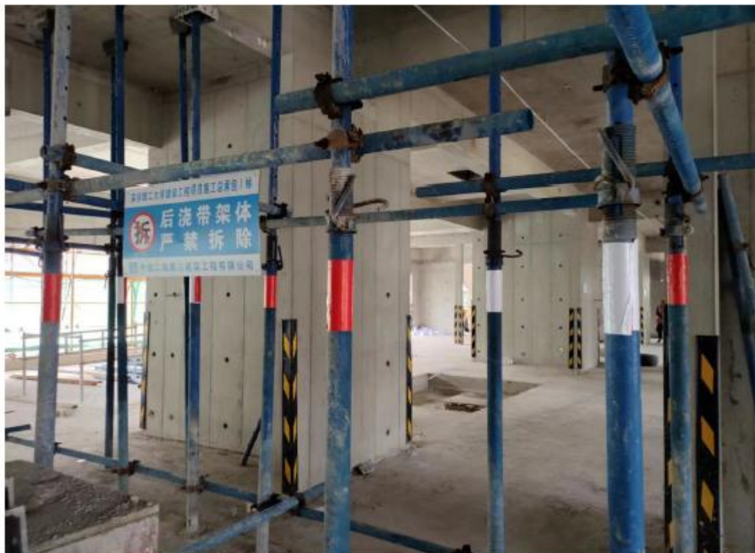
图 6.12.4 后浇带支撑体系
