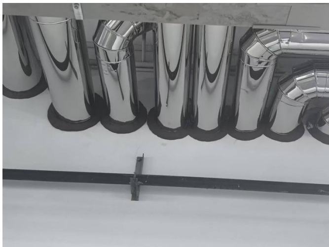
图 12.6.2.3-1 封堵标准做法示意
