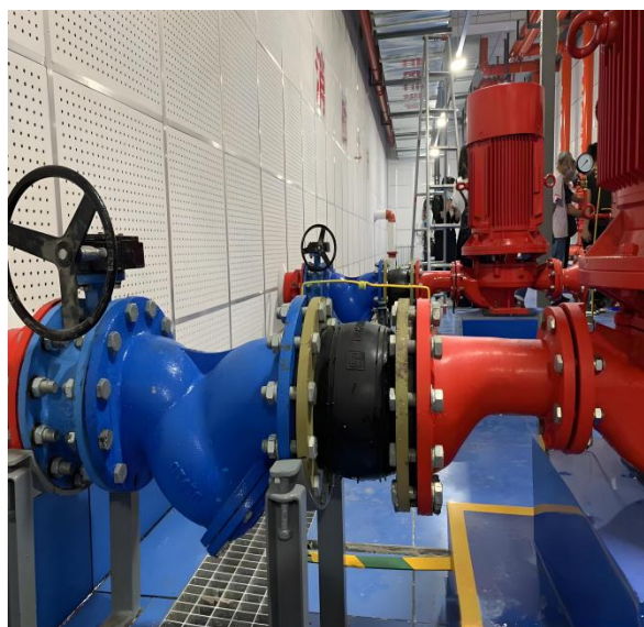
图 11.4.1.6 管道法兰连接
