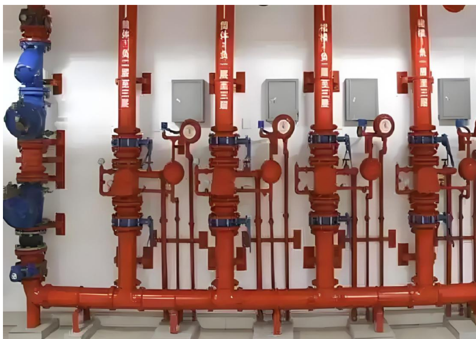
图 12.1.3.1-1 警铃安装在室内不符合规范
