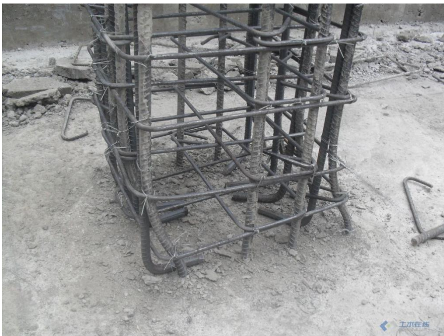
图 6.7.1-1 柱钢筋偏移
