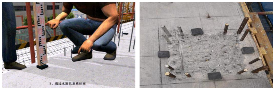
图 7.5.3-4 垫片放置、标高抄测
