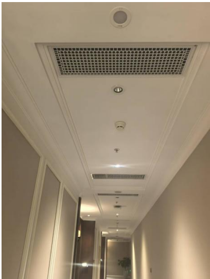
图 12.4.3-1 烟感标准安装示意
