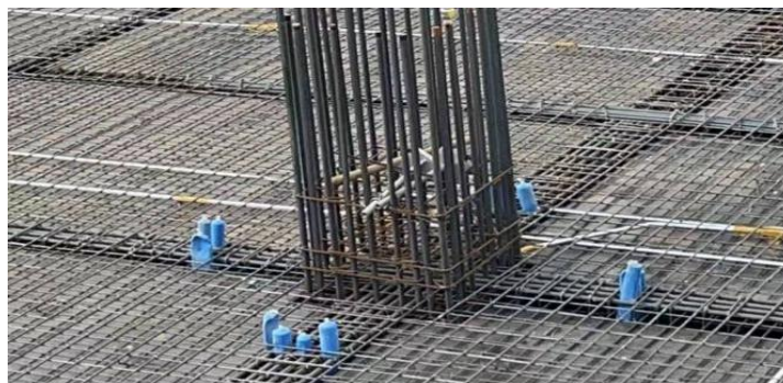
图 6.5.4-1 框架柱梁交界区域气囊隔断措施
