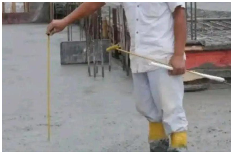
图 6.8.3-3 采用插钎法控制标高
