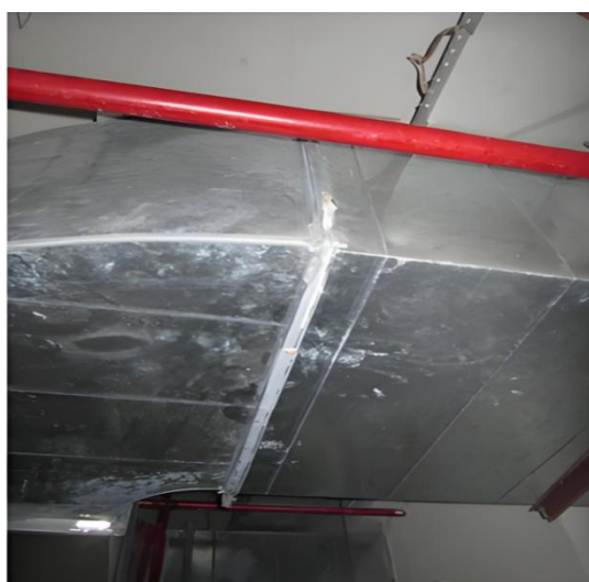
图 11.5.3.1 风管连接处漏风
