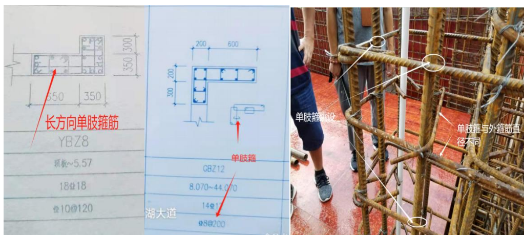
图 5.10.1 短肢柱单肢箍设置缺陷
