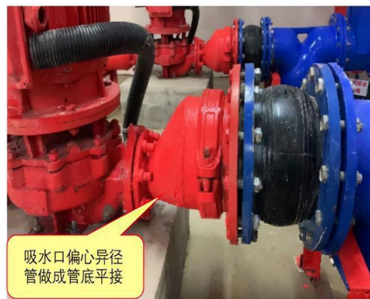
图 12.1.4.1-2 水泵偏心异径管低平接
