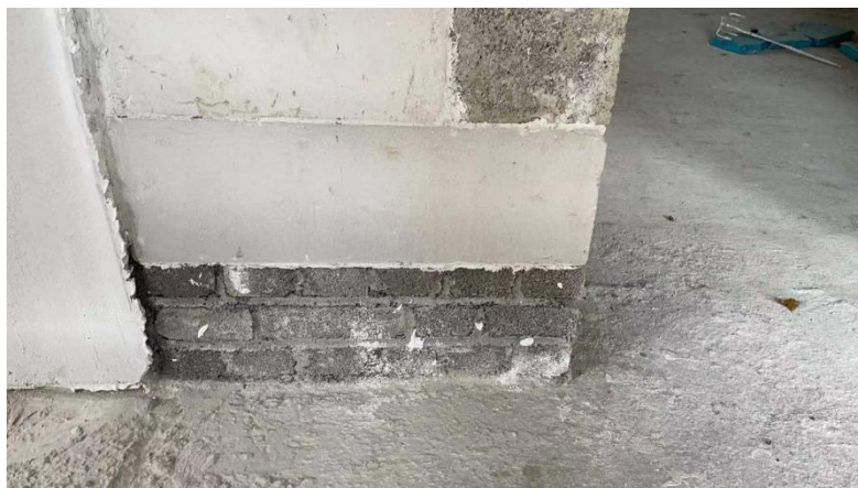
图 9.1.2.3 底部设置墙垫
