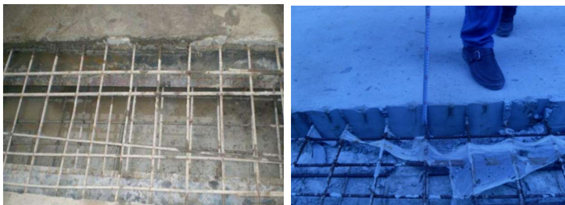
图 6.10.1-1 后浇带板面钢筋保护层太厚
