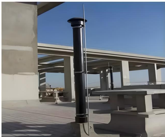
图 11.7.5.2 屋面管道接地保护
