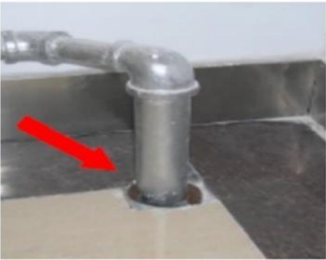
图 12.6.2.1-1 封堵套管高度过低
