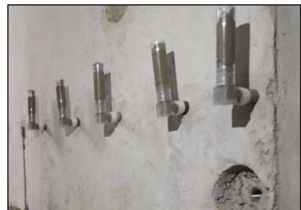
图 7.3.3.3-5 套筒灌浆浆料补偿器实物图
