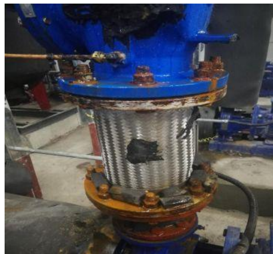
图 11.4.1.4 法兰漏水
