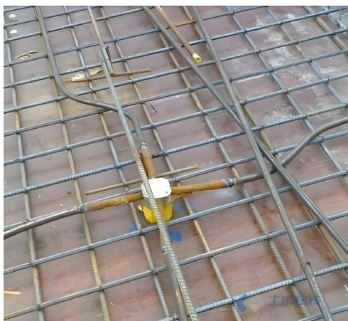
图 11.2.5.1 金属线管对接焊接
