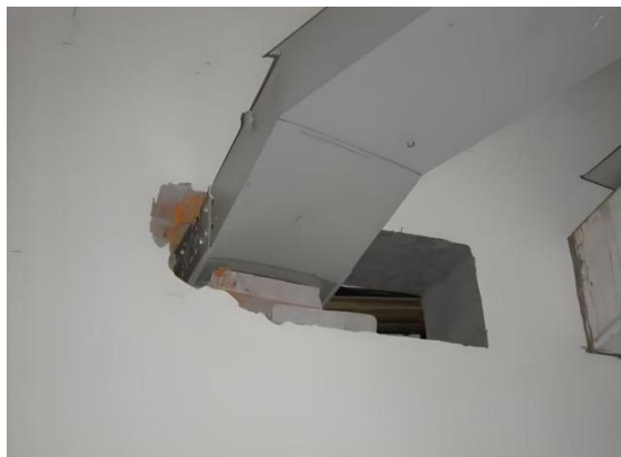
图 11.3.3.1 桥架接头设置在套管内
