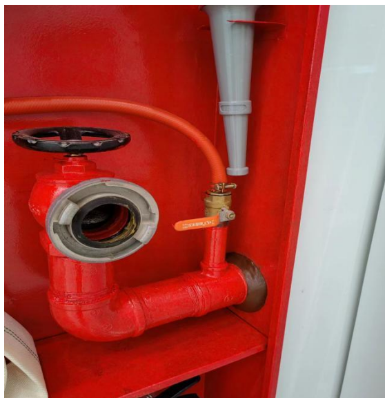
图 11.4.1.5 管道螺纹连接
