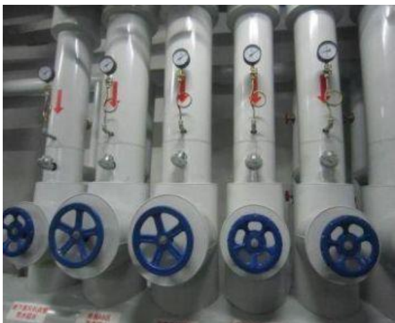
图 11.4.2.3 垂直管道仪表安装
