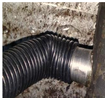
图 7.3.2-1 套筒进出浆孔管道安装弯折、扭曲
