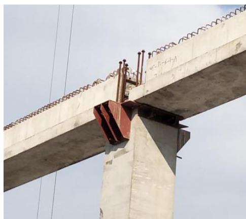
图 7.5.3-3 预制柱+牛腿支撑预制梁
