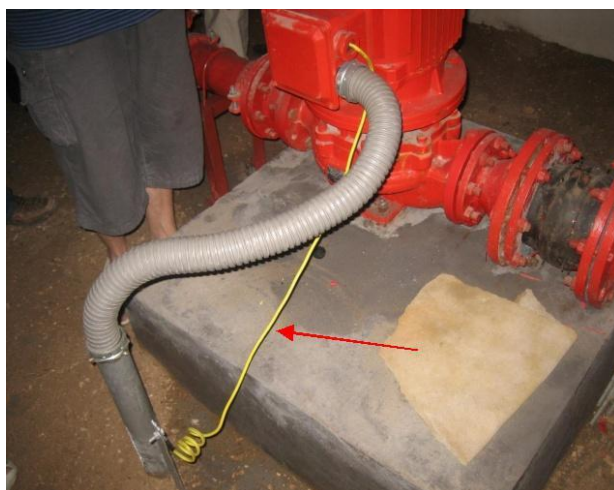
图 11.7.4.1 水泵接地错误
