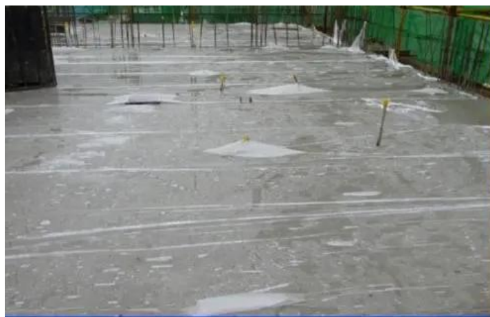
图 6.1.3 混凝土薄膜覆盖养护
