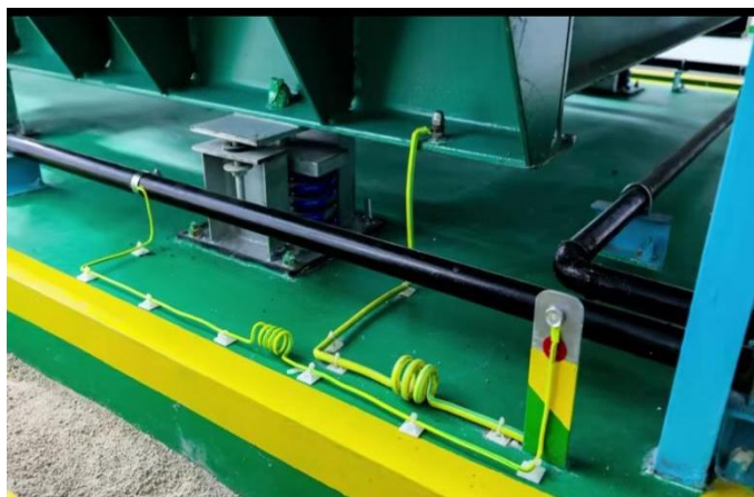
图 11.7.4.2 设备接地保护
