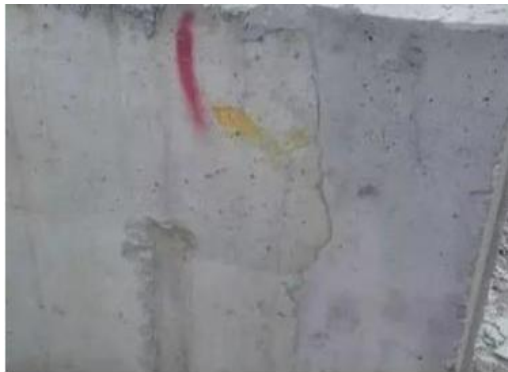
结构柱裂缝
