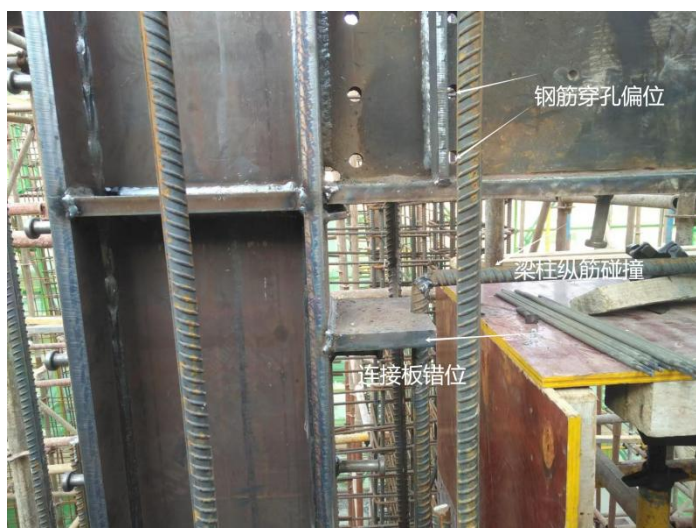
图 5.2.1 劲性结构节点钢筋连接错误
