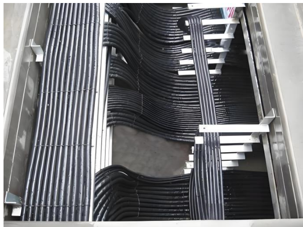
图 11.2.9.4 电缆沟内电缆敷设
