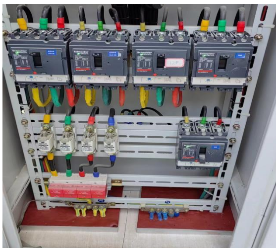
图 11.2.7.2 相线颜色规范设置
