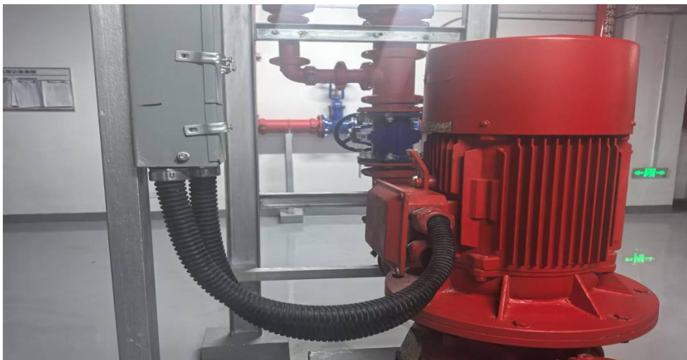
图 12.1.7.3-1 水泵电缆标准做法
