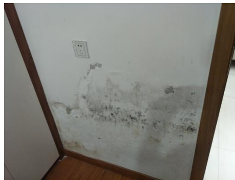
图 10.11.1-1 顶楼厨房烟道、管道井与顶板 图 10.11.1-2 卫生间墙面渗漏水导致墙体潮湿、发霉 交接处渗漏
