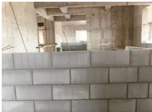
图 8.1.3-4 每日砌筑高度不应超过 1.5m
