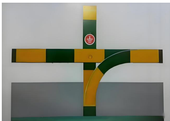
图 11.7.2.3 接地扁铁搭接
