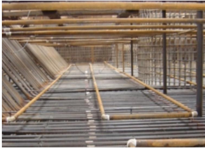
图 6.14.4 大体积混凝土冷却循环水管降温
