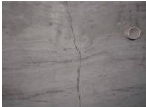
剪力墙裂缝
