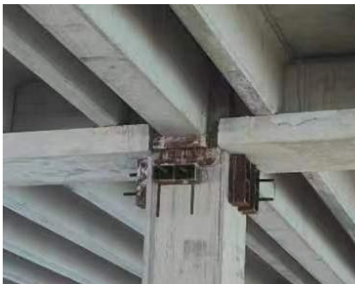
图 7.6.2-1 现浇节点线条复杂、空间狭小示意
