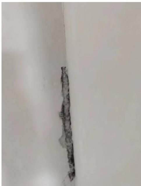
图 9.3.1.1 石膏轻质隔墙板开裂
