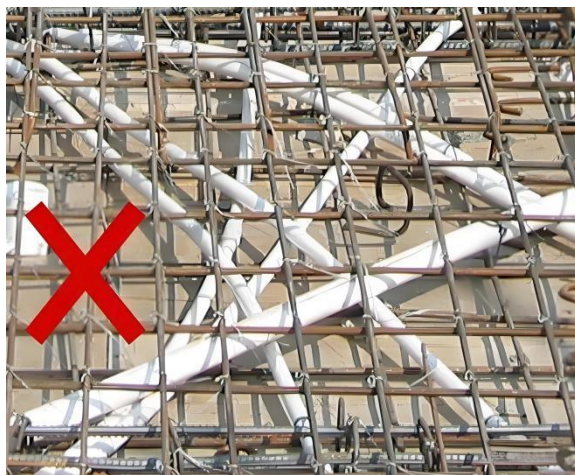
图 11.1.2.2 水平预埋管线过于集中
