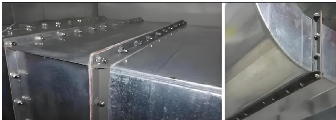
图 11.5.3.2 风管法兰连接
