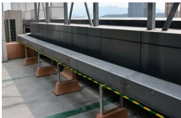
图 11.3.5.1 室外防水桥架安装
