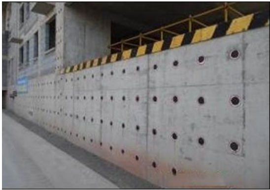
图 10.2.3-4 外露部分螺杆处理示意图
