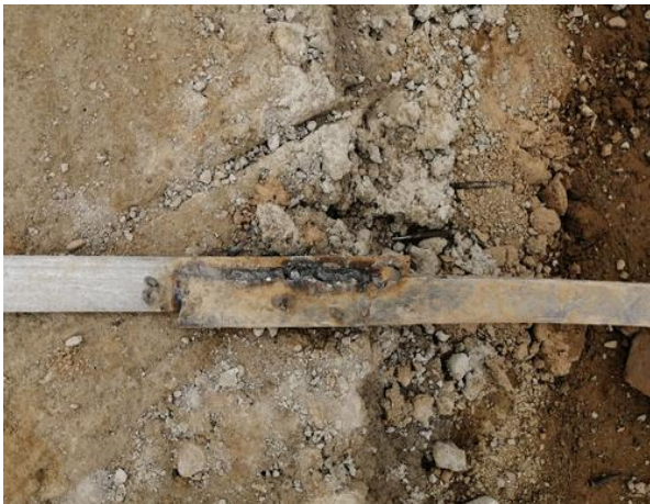
图 11.7.2.1 扁铁搭接长度错误
