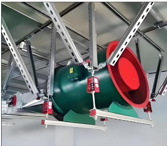
图 11.6.2.2 悬吊式设备减震器安装
