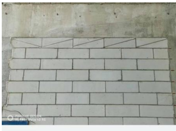
图 8.1.3-3 顶面与上部结构接触处砌一皮
