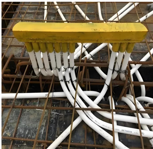
图 11.1.5.3 预埋线管端口保护
