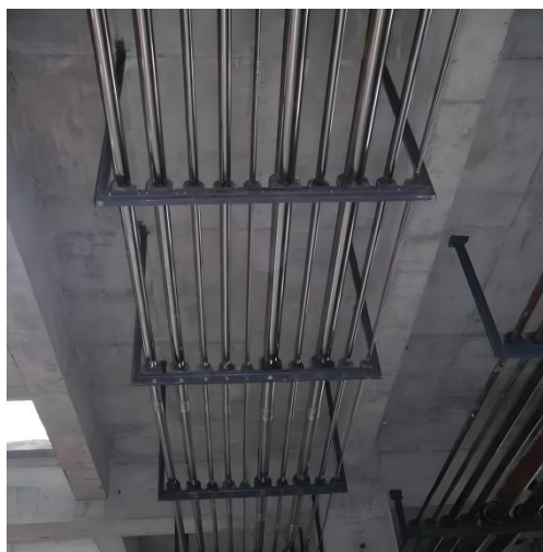
图 11.4.3.5 非金属隔垫安装
