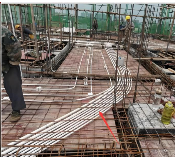
图 11.1.2.4 水平线管间距合理
