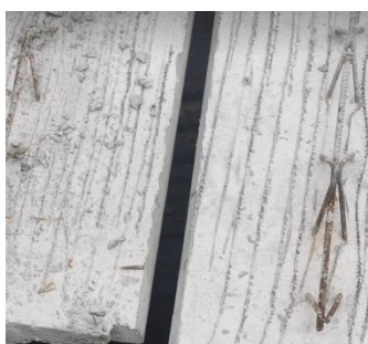
图 7.5.1-1 构件缝隙大
