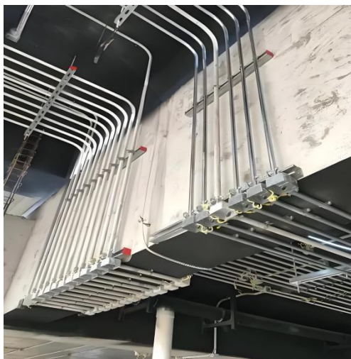
图 11.2.4.2 线管连续翻弯设置过线盒
