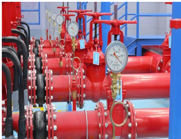
图 11.4.2.4 水平管道仪表安装
