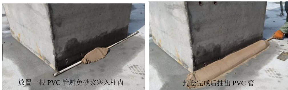
图 7.3.3.3-2 砂浆封仓示意图
