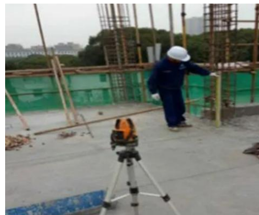
图 6.8.3-4 采用激光找平仪控制标高
