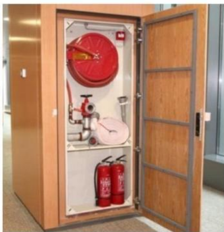
图 12.2.3-1 消火栓标准安装标准做法
