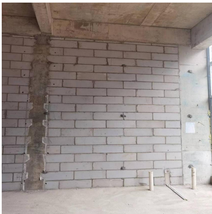
图 8-4-1-6 构造柱不需要留置马牙槎
