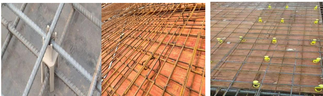
图 5.3.3 垫块及马凳筋按要求布置
