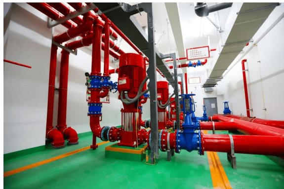
图 12.1.1.3-2 立式泵规范安装
