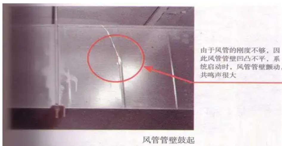
图 11.5.2.1 风管管壁鼓起
