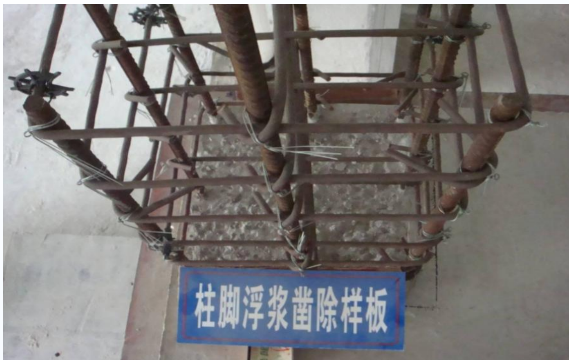
竖向结构剔除浮浆
