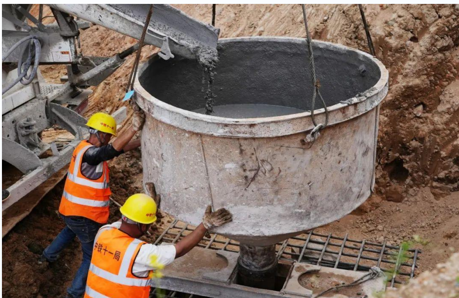
正确的浇筑方式
