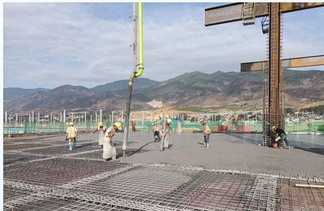
“赶浆法”施工保持浮浆厚度
