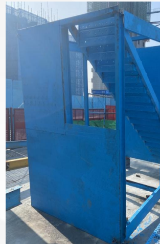
花纹钢板与支撑焊接喷漆
