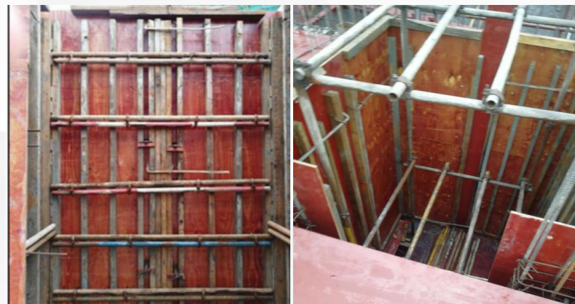
减少电梯井架体对井道支模影响
