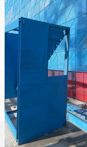
花纹钢板与支撑焊接喷漆
