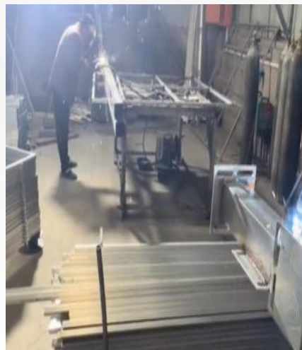
槽钢焊接组装
